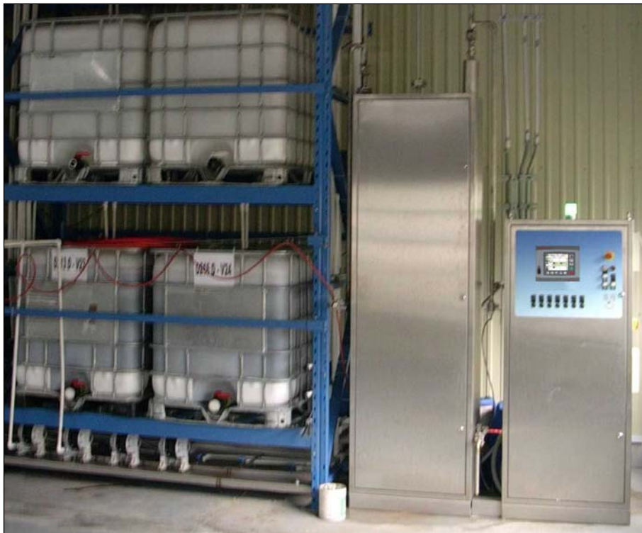
Schema Chemikaliendosiersystem CDS
